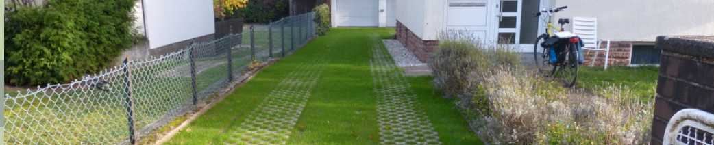
Entsiegelung von Zufahrt und Hinterhof durch Rasengittersteine auf einem Grundstück in Bothfeld (Foto: Gerd Wach)
